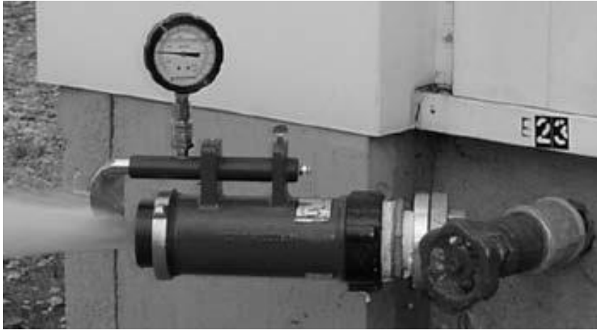
Slika 7. Mjerenje pomoću Pitot cijevi s kalibriranom mlaznicom Figure 7. Taking nozzle pressure with a Pitot tube and calibrated nozzle
